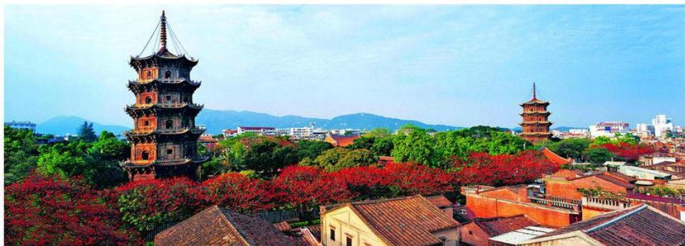
我国现存最高的石塔——泉州东西塔
